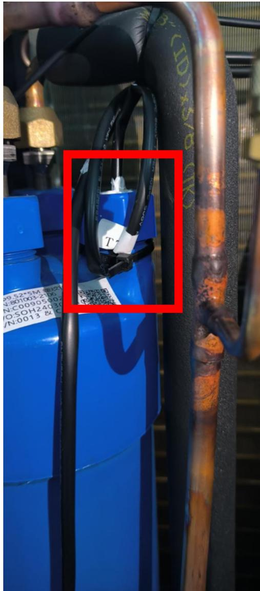
1. Die Auslasswassertemperatur überschreitet den Schwellenwert des Systems, niedrige Wasserdurchflussrate, Wasserpumpenanomalie. Überprüfen Sie, ob das Wasserventil oder die Wasserpumpe geöffnet ist.
