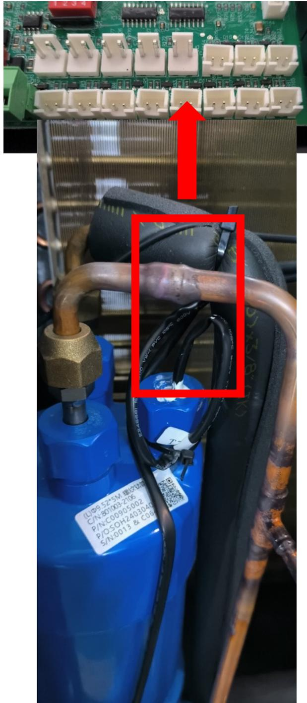
1. Überprüfen Sie, ob der Sensor und sein Kabel beschädigt sind
