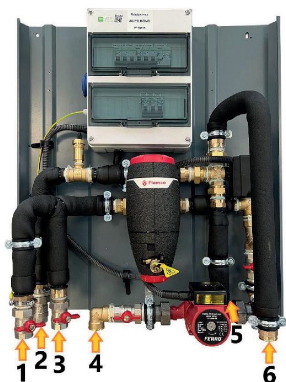
Abb. 7 Hydraulischer Anschlusschema
